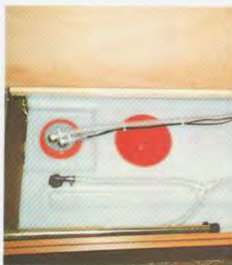
Wintertaugliche Verlegung der Wasserver- und -entsorgung.
